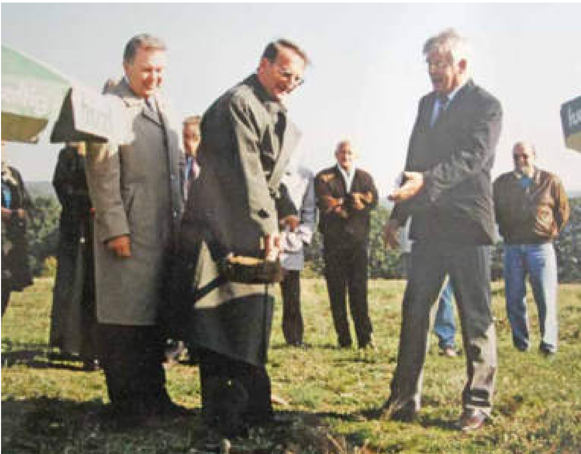
Bürgermeister Theo Ratzka, Landrat Karl Eyerkauf und Präsident Gerd Müller beim Spatenstich zum Bau der heutigen Anlage 1992
